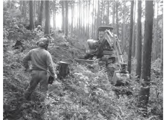
バックホウによる盛土の施工方法を学ぶ研修生
