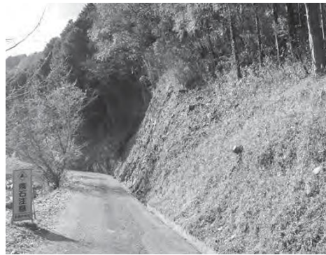
道路支障木伐採状況（小森地区）
