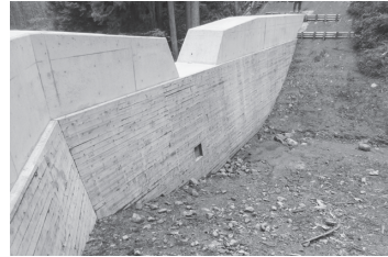
写真1 木製残存型枠
