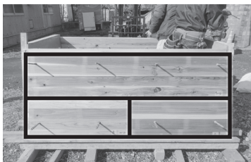
写真3 型枠組立状況
