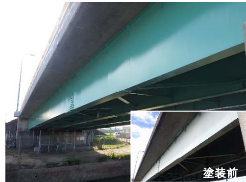
児島湾地区(岡山市南区) 【橋梁の塗装】
