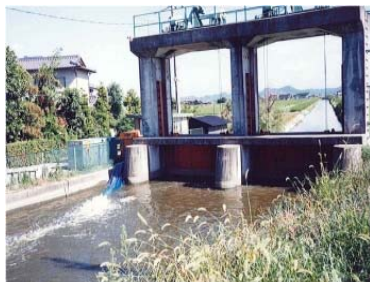
ポンプアップ(大水門)
