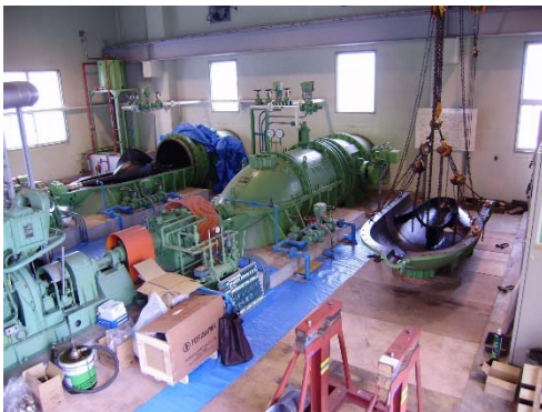
瀬戸地区(岡山市東区) 【排水機の分解整備】
