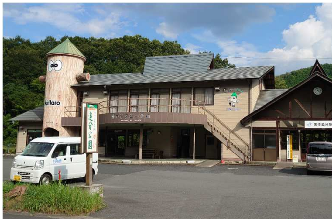
美作追分駅舎トイレ改修工事
