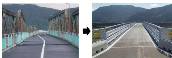
令和5年5月8日、一級河川高梁川に架かる川辺橋の橋脚1基が、前日までの豪雨の影響により基礎に著しい洗掘を受け、上流側に約1m傾斜しました。川辺橋の通行が危険な状態となつたため、ただちに全面通行止めとし、緊急措置として上流にある新川辺橋の路肩に歩行者・自転車の通行帯を整備しました。
