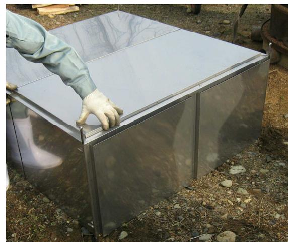
本体設置後、フタをのせフタの収まり具合を確認します。きちんと入らない場合は、フタが収まるよう本体の歪みを修正します。
