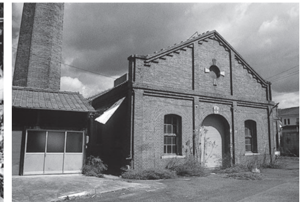
解体(平成1年)前の下村紡績所
