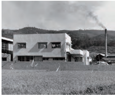
工場外観/ベティスミス
