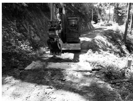
横断工として土木用CLTを利用
