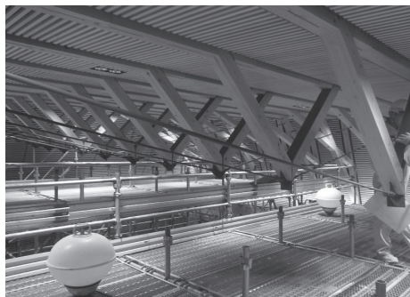
新庁舎建設状況〔議会棟天井部〕 (構造材はH鋼と美作市産材の組み合わせ)
