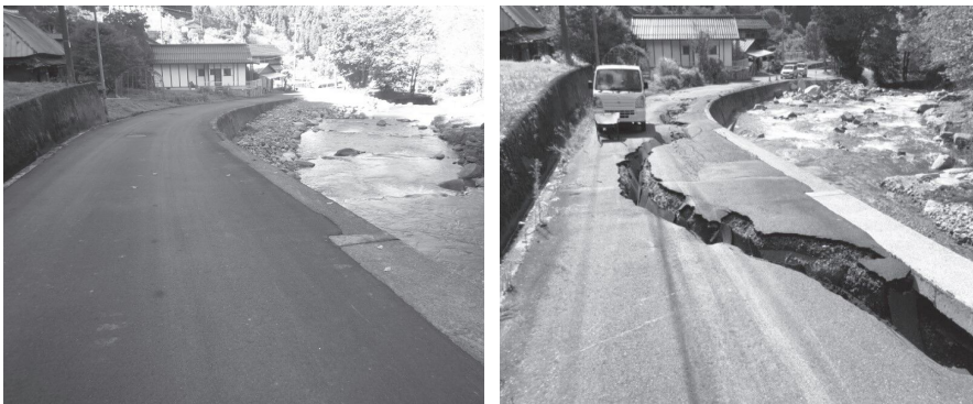
林道落合線(津山市)の復旧状況【左:復旧後、右:被災時】
