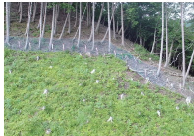
▲ 植栽地へのシカ防護柵の設置
