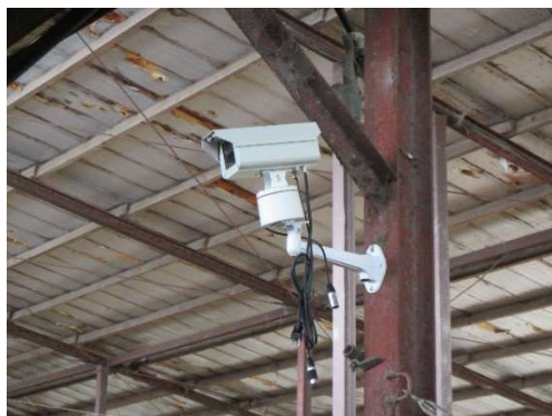
設置したレーザー
