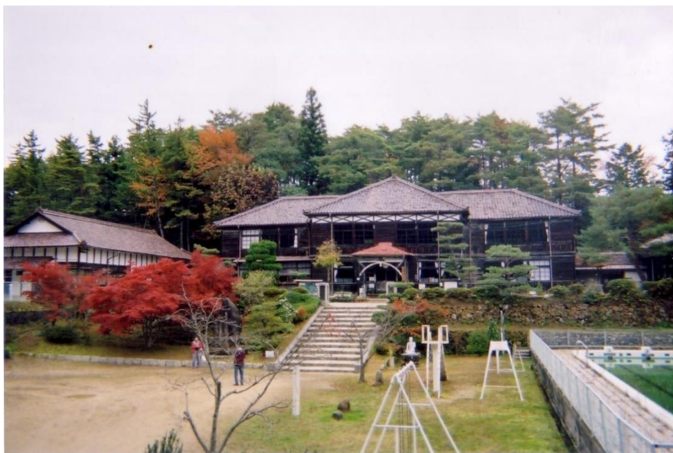
ア 旧吹屋小学校
