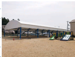
吉永屋根付き多目的広場 「なかYOSHIパーク」
