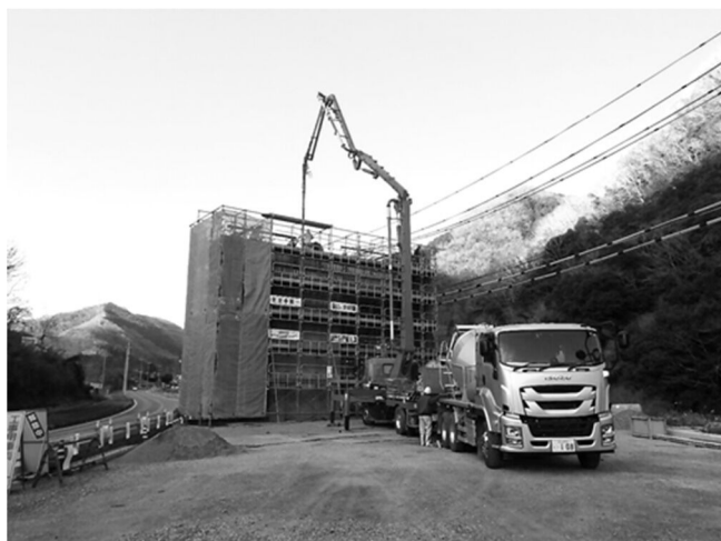
光木高架橋(仮称) P2 橋脚施工状況
