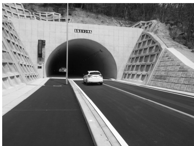
第3トンネル状況(起点側より)
