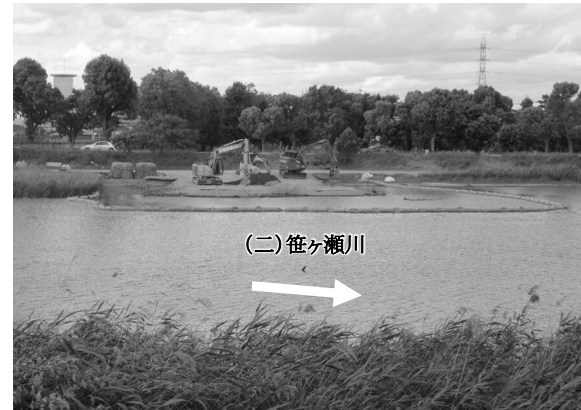
河道掘削状況
