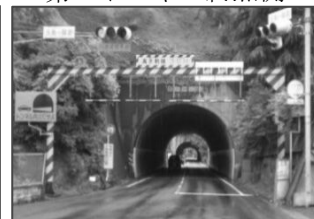
第1トンネル終点側
