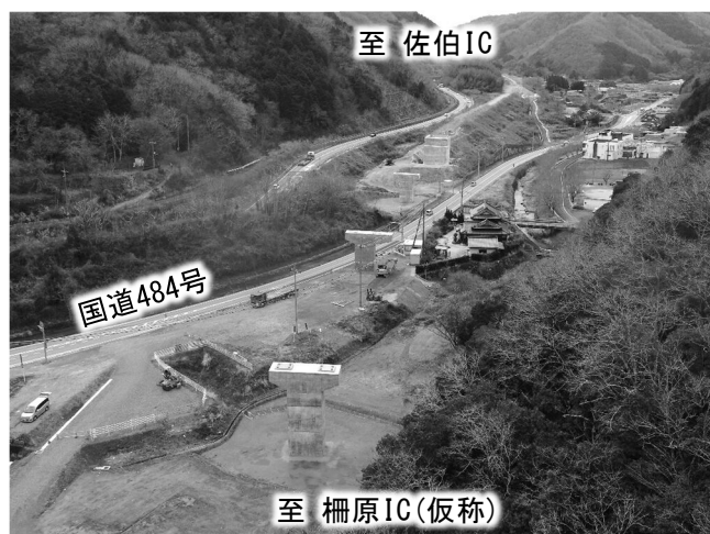
光木高架橋(仮称)付近の現況
