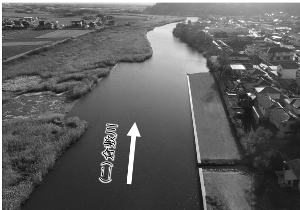
河道掘削状況
