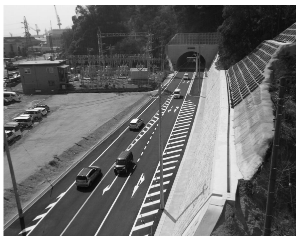
第2トンネル状況(第1トンネル側より)
