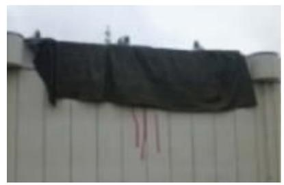
外壁の破損を想定した養生訓練
