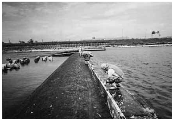
パネル設置作業状況
