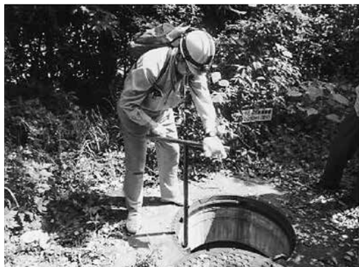
2ルート配水管路の切替作業状況
