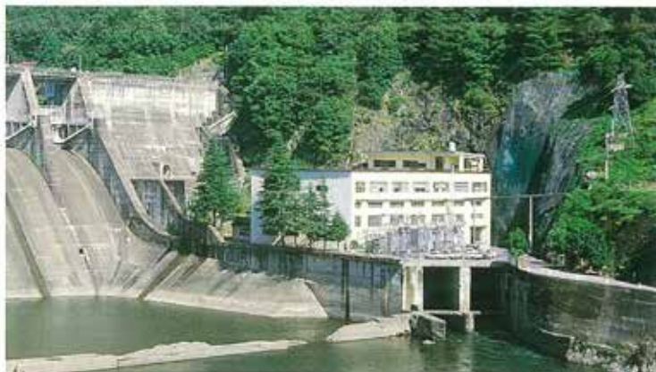
ダム直下の第一発電所
