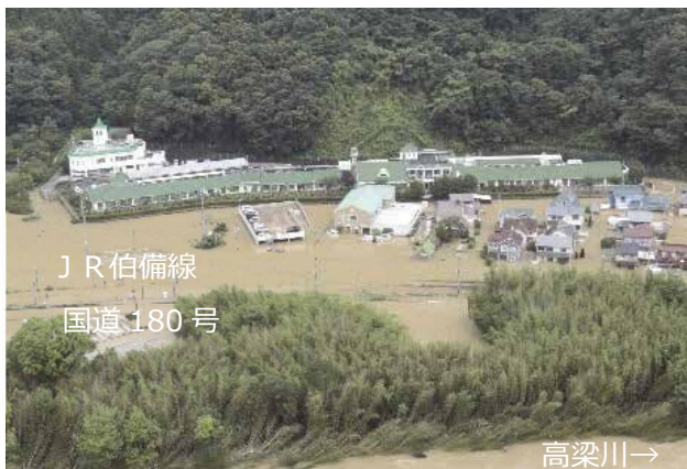
浸水状況（作原地区：特別養護老人ホーム）
