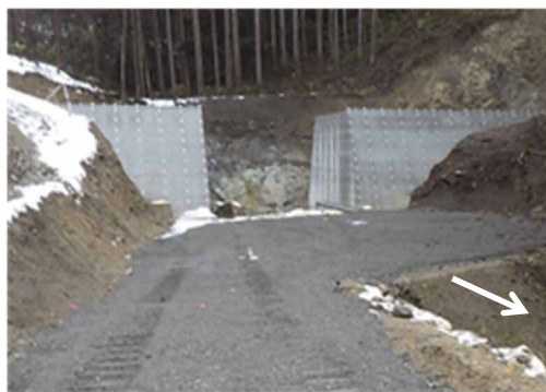
施工状況（太田谷川）
