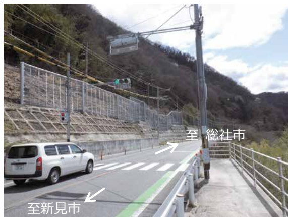
国道180号（高梁市）落石防護工
