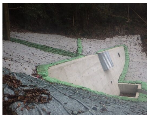
山腹工（土留工等）による山腹崩壊の防止
