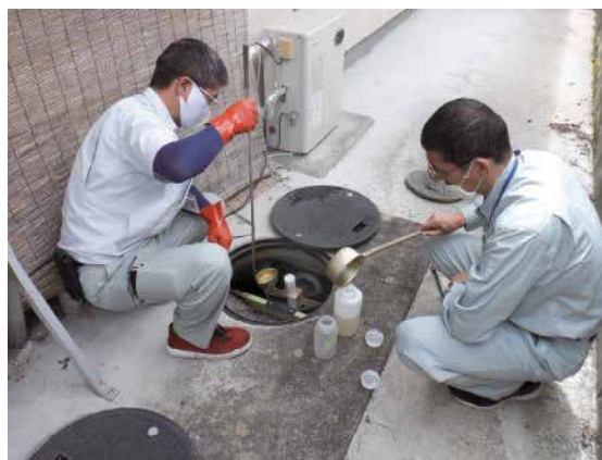
(浄化槽の使用状況の確認)
