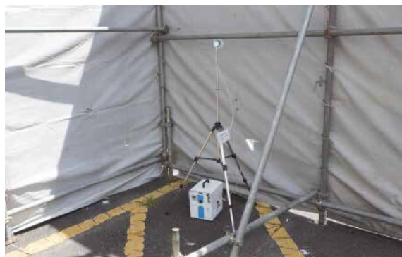
(解体工事現場でのアスベスト測定)
