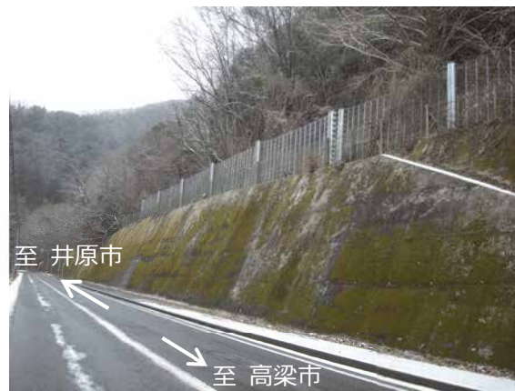
国道313号（井原市）落石防護工
