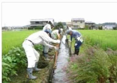
水路の泥上げ
