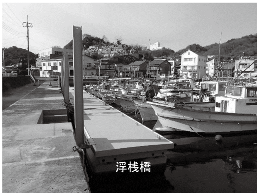
下津井漁港（浮棧橋の更新）
