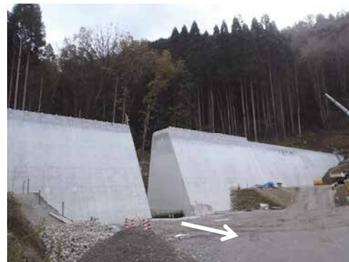
施工状況（小岸谷川）
