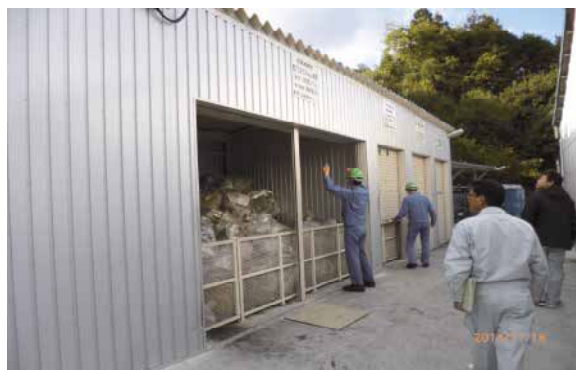
立入検査（産業廃棄物の保管状況の確認）
