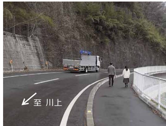
県道新見川上線〈歩道〉（新見市）
