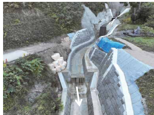
施工状況（今井谷川）
