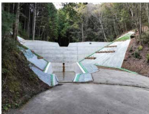
溪間工（治山ダム）による土砂流出の抑制
