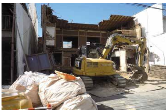
解体現場への立入検査
