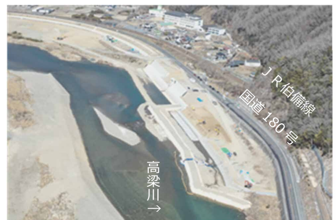
施工状況（作原地区）
