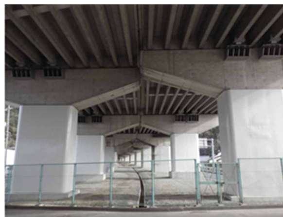
県道藤戸連島線 連島1号高架橋 落橋防止工
